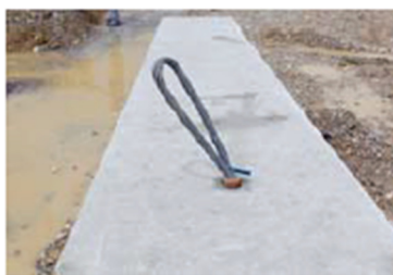
1 Lastanschlagpunkte an vorgängig festgelegten Stellen montieren.
