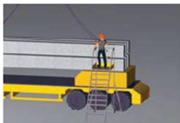
2 Beim An- und Abhängen ab 2,0 m Absturzhöhe Hilfsmittel, lange Anschlagmittel oder Anseilschutz verwenden.
