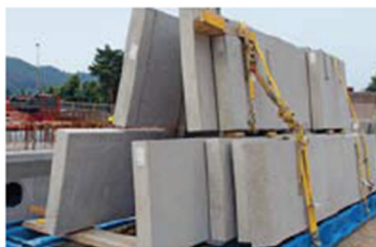
3 Bauteile gegen Umkippen sichern.
