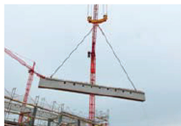
2 Asymmetrische Lasten korrekt anschlagen.
