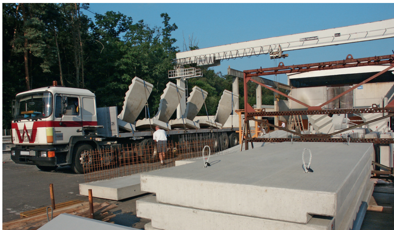
Einsatz der Seilschleife SS im Elementwerk.
